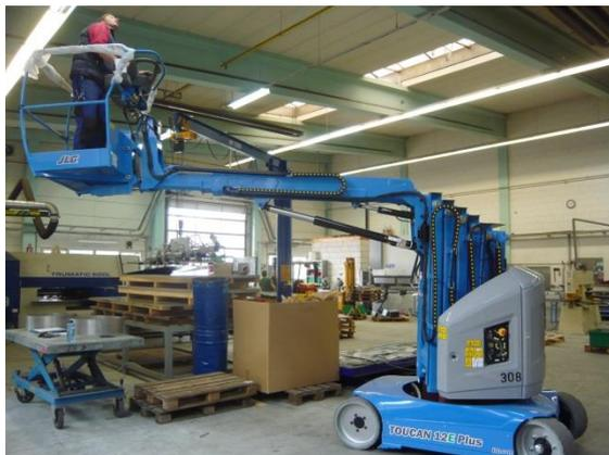
BU: Der Austausch der Leuchtkörper erfolgte mit einer mobilen Hebebühne, so dass die laufende Produktion praktisch ungehindert weiterlaufen konnte.
